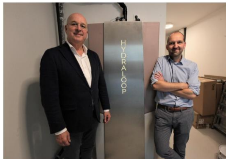
Ceo Arthur Valkieser en bewoner David Mertens bij de Hydraloop die hij in zijn berging liet installeren. © atb
